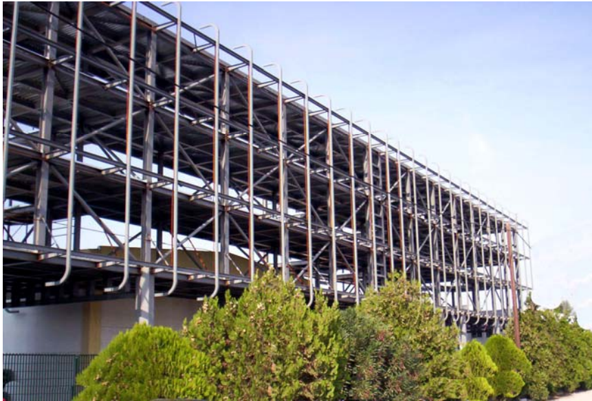
Φωτ. 1: Ο φέρων οργανισμός του κτιρίου (άνοιξη του 2005)
