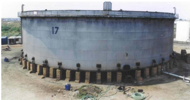
Φωτ. 4: Η δεξαμενή [TK-17] στην τελική θέση ανύψωσης
