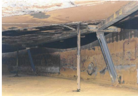
Φωτ. 1, 2: Λεπτομέρειες των διατάξεων ανύψωσης, στήριξης και ανάρτησης
