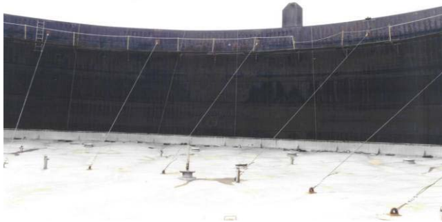
Φωτ. 3: Διάταξη συρματόσχοινων στο εσωτερικό της δεξαμενής
